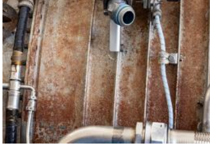
Şekil 17. Korozyon(Corrosion)
